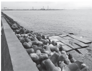
図8 被覆ブロック設置 Fig. 8 Covering blocks (Ferroform blocks)
