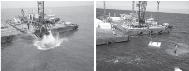
図7 人工石およびブロック設置状況 Fig. 7 Installation of stones and blocks
